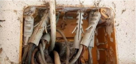
Gefährliche Alltagselektrik entdeckt: Dübel bieten keinen Kontakt-schutz für Leiterenden. Foto: privat
