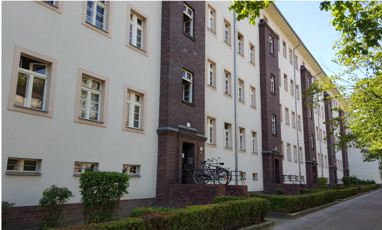
Häuser, die vor 1970 erbaut worden sind, stellen Elektroinstallateure vor Herausforderungen, wenn es darum geht, in diesem Gebäudebestand elektrische Anlagen zu erweitern. Häufig weisen sie noch die klassische Nullung auf, die jedoch seit 1973 nicht mehr zulässig ist. Foto: getty images
