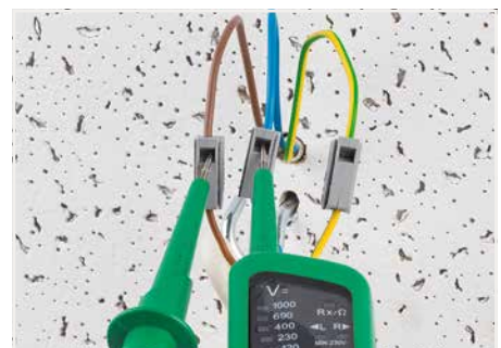
Prüfen in separater Prüföffnung
