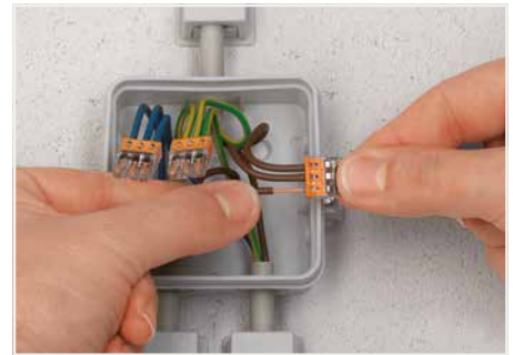
Anschließen: Abisolierten eindrächtigen Leiter bis zum Anschlag einstecken.
