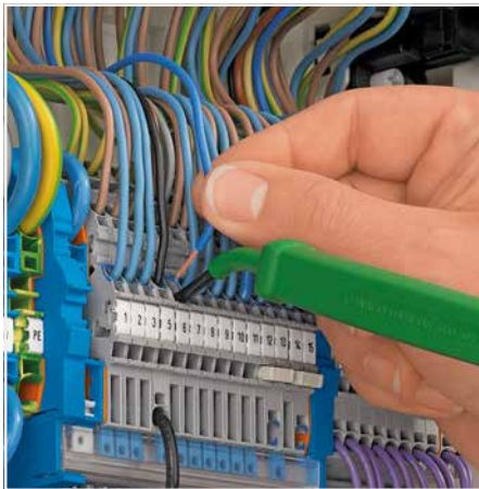
Öffnen der Klemmstelle mit Betätigungswerkzeug
