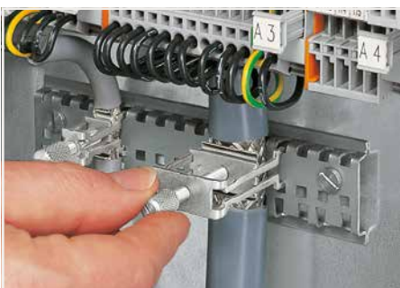
Festdrehen/Lösen eines Schirmklemmbügels
