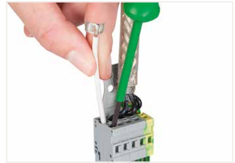
Schirmübergabe mittels Betätigungswerkzeug in die Federleiste einsetzen.
