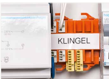
Anwendung für eine Hausklingelanlage – Befestigung auf Tragschiene 35
