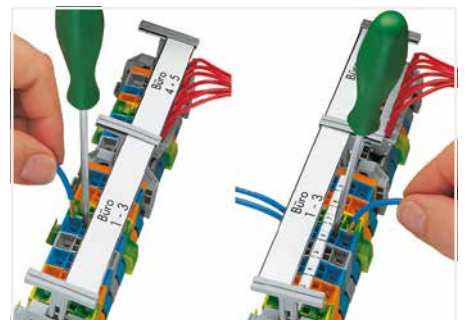
Seitlich verschiebbares Beschriftungssystem
