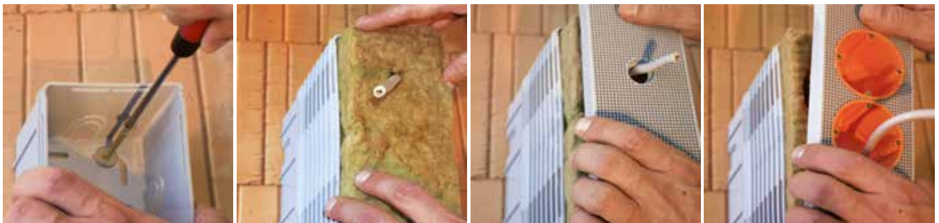
Bild 19: Türkommunikationsanlage an gedämmter Fassade auf Geräteträger montiert
