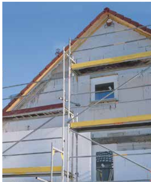
Bild 17: Dämmung der Außenfassade
