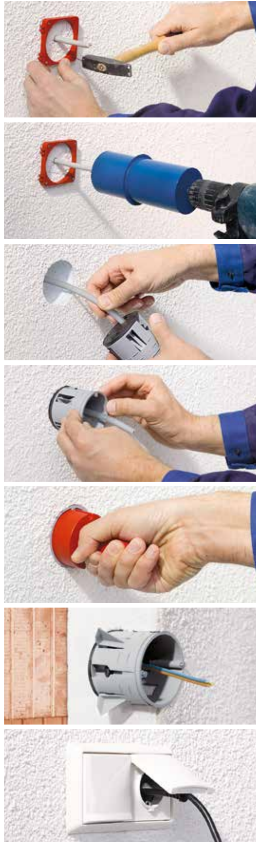
Bild 25: nachträglicher Einbau von Steckdosen in die gedämmte Außenfassade
