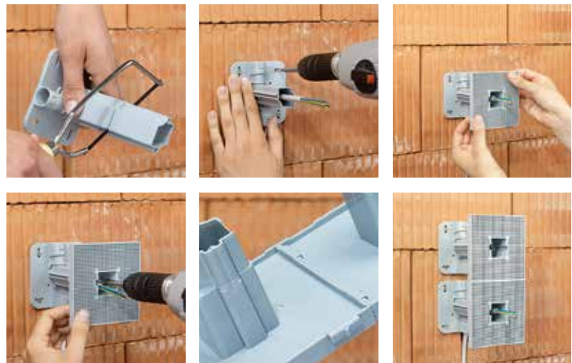
Bild 22: Montage eines Teleskop-Geräteträgers
