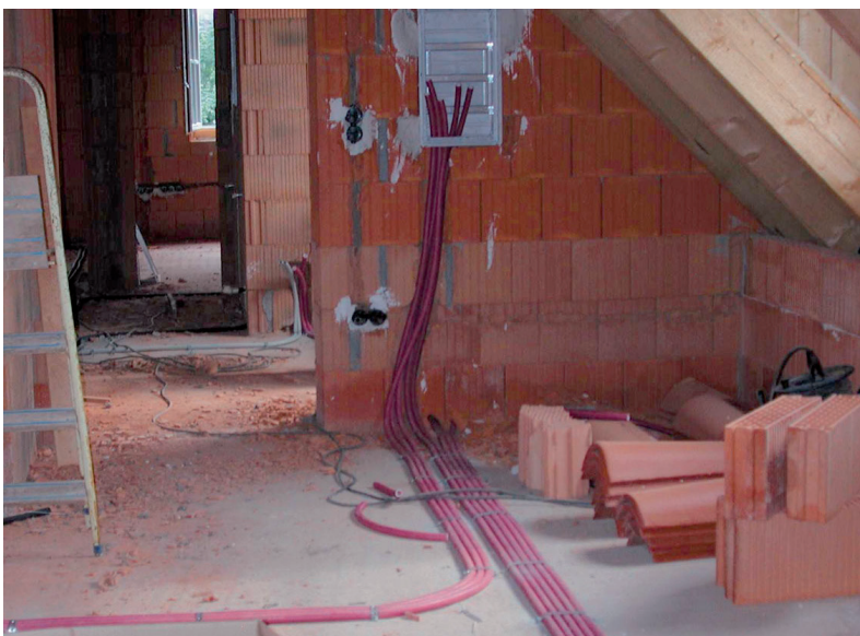
Bild 9: Einbau von Elektroinstallationsrohren für zukunfts-trächtige Elektroinstallationen
