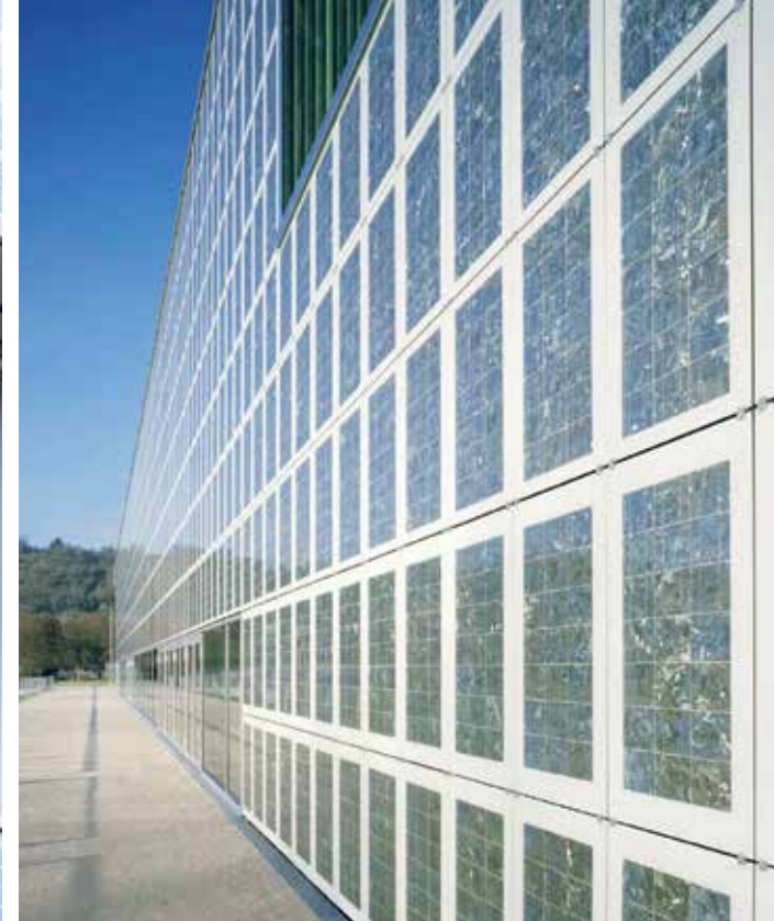
Polykristalline Zellen. Elemente/ Paneele. In die Fassade integrierte farbige Module.
