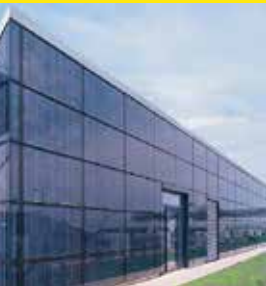
Polykristalline Zellen. Hybride. Integration in Fassade und Dach.
