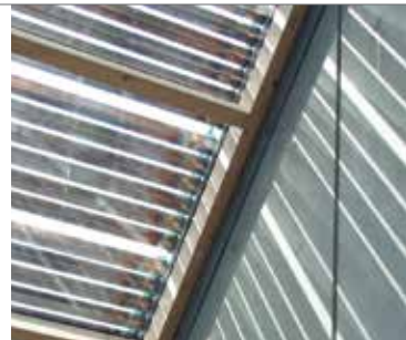
Vakuum-Röhrenkollektoren als Beschattungselemente vor der Verglasung im Treppenhaus. kämpfen für architektur, Mehrfamilienhaus. Dübendorf, Schweiz.
