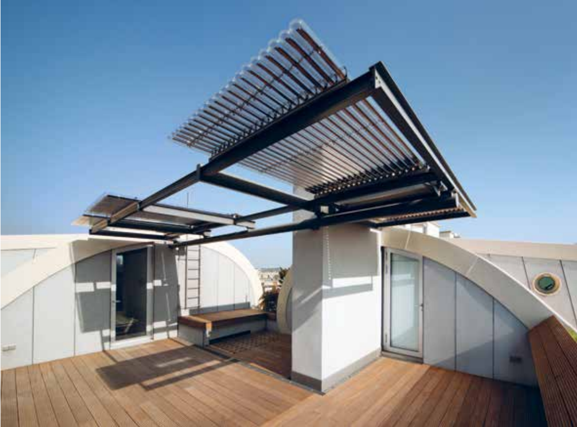
Vakuum-Röhrenkollektoren als Beschattungselemente auf einer Dachterrasse.
