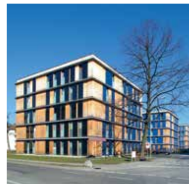
Die Südfassade dieser Wohnanlage ist mit Photovoltaik-Modulen auf Schiebeläden bestückt, die sich als Kontrast von der Holzfassade abheben. Arch. Hermann Kaufmann, Wohnbau. 6971 Hard, Spinnereistraße.
