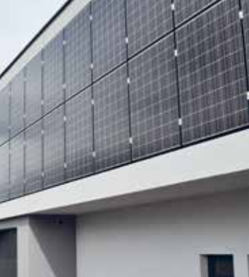
Die Photovoltaikpaneele werden in die Fassade integriert. Architekt Nikolaus Holstein, Einfamilienhaus. Mannswörth, Niederösterreich.
