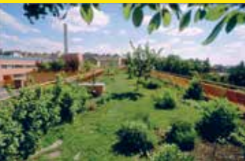
BKK2, Wohnhausanlage Sargfabrik. 1140 Wien, Goldschlagstraße 169. Foto Firma Dachgrün
