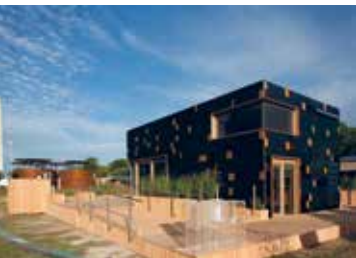
Schindelartige Montage der Photovoltaik-Paneele auf der Fassade. TU Darmstadt Solardecathlon, Solarhaus. USA.
