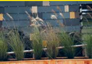
Detail von schindelartigen Photovoltaik-Paneelen an einer Fassade. TU Darmstadt Solardecathlon, Solarhaus. USA.
