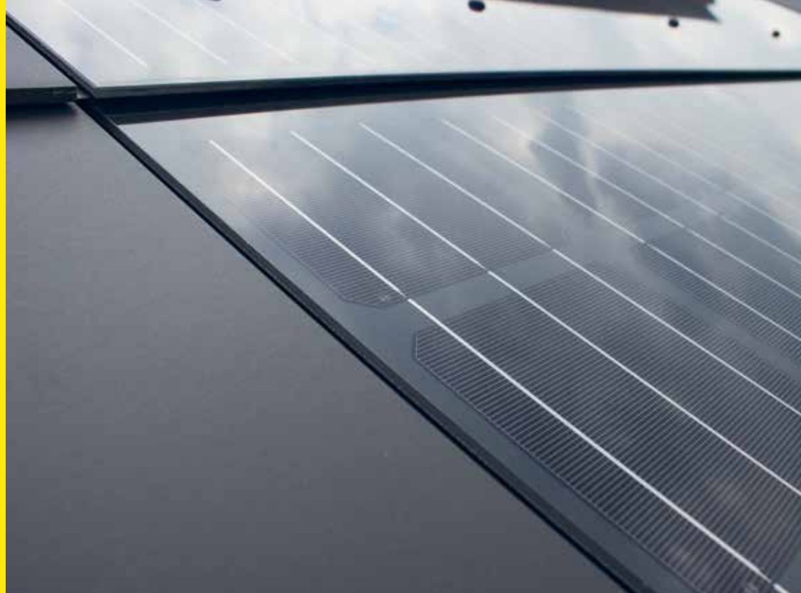
Monokristalline Zellen. Elemente/ Paneele. Erscheinungsbild der Ober- fläche von rahmenlosen gebäudein- tegrierten Photovoltaik-Modulen.
