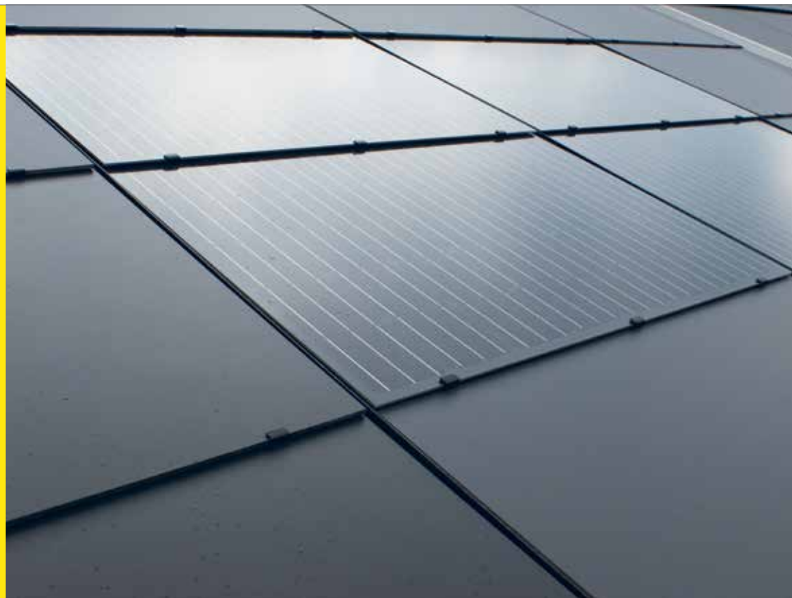
Monokristalline Zellen. Elemente/ Paneele. Die Ausführungsbeispiele zeigen eine Aufdachlösung und eine gebäudeintegrierte Photovoltaikan- lage im Vergleich.
