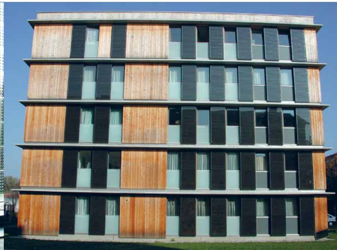
Die Südfassade dieser Wohnanlage ist mit Photovoltaik-Modulen auf Schiebeläden bestückt, die sich als Kontrast von der Holzfassade abheben. Arch. Hermann Kaufmann, Wohnbau. 6971 Hard, Spinnereistraße.
