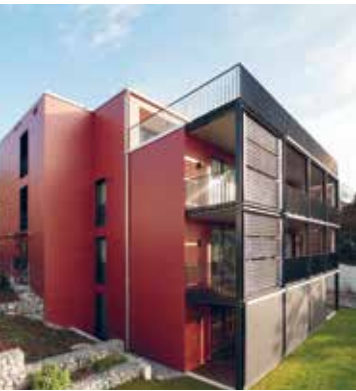
Vakuum-Röhrenkollektoren als Sichtschutz vor dem Balkon. kämpfen für architektur, Mehrfamilienhaus. Zürich-Höngg, Schweiz.
