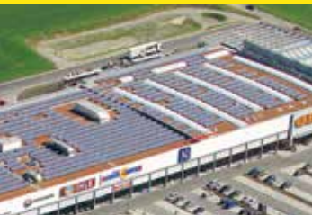
Einkaufszentrum InCenter mit Photovoltaik-Modulen und extensiv begrüntem Dach (Sedumteppich). Architekturbüro Drenske. Landsberg/Lech, Deutschland.
