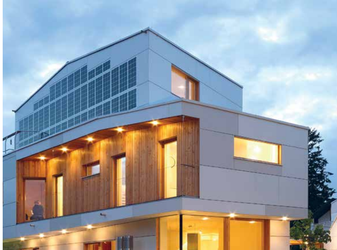
Integration von Photovoltaik-Modulen in einer Fassade aus Faserzementplatten. Das grafische Muster der Anordnung unterstreicht die architektonische Form. RAHM Architekten, privates Wohnhaus. Wien.
