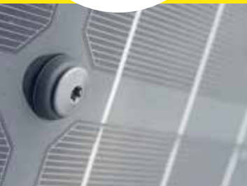
Monokristalline Zellen. Elemente/ Paneele. Erscheinungsbild der Ober- fläche von rahmenlosen gebäudein- tegrierten Photovoltaik-Modulen.
