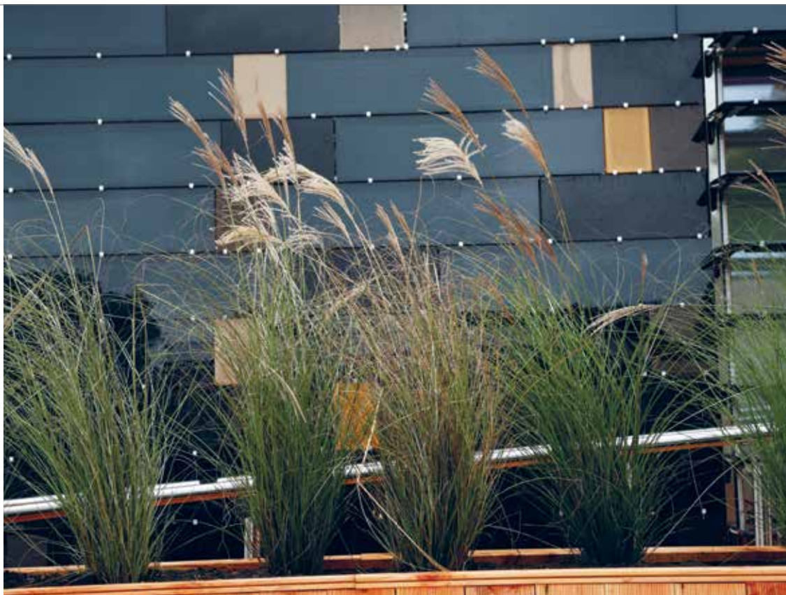
Schindelartige Montage der Photovoltaik-Paneele auf der Fassade. TU Darmstadt Solardecathlon, Solarhaus. USA.
