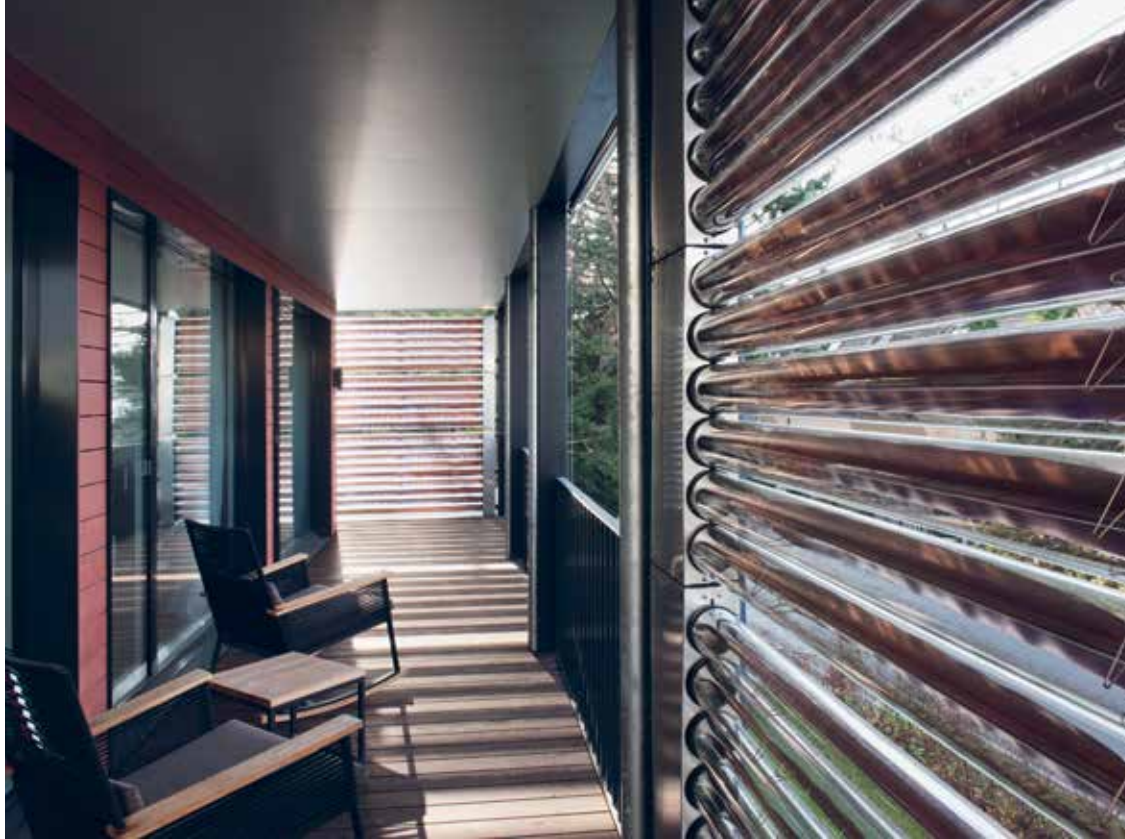
Vakuum-Röhrenkollektoren als Sichtschutz vor dem Balkon. kämpfen für architektur, Mehrfamilienhaus. Zürich-Höngg, Schweiz.
