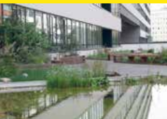
Versuchsanlage der MA 22 zu verschiedenen Dachbegrünungen. 1200 Wien, Dresdner Straße 45
