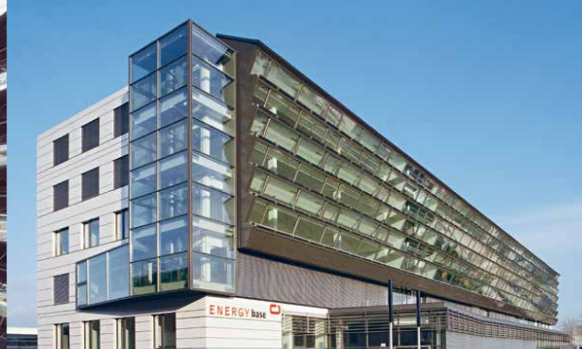
ENERGYbase nutzt die Kraft der Sonne 4-fach: zweimal passiv und zweimal aktiv. Die passiven thermisch solaren Gewinne werden direkt den Südräumen und indirekt den Nordräumen zugeführt. Die spezielle Form der gefalteten Fassade bewirkt dabei, dass diese Gewinne nur im Winter anfallen, im Sommer verschattet sich die Fassade zunehmend selbst. Die Photovoltaik-Anlage ist gebäudeintegriert an der Südfassade und liefert jährlich rund 43.600 kWh Solarstrom. Solar cooling mit thermischen Kollektoren. Sie werden für die Frischluftkühlung und -entfeuchtung und zur Heizungseinbindung verwendet. pos architekten, Bürogebäude. 1210 Wien, Giefinggasse 6.
