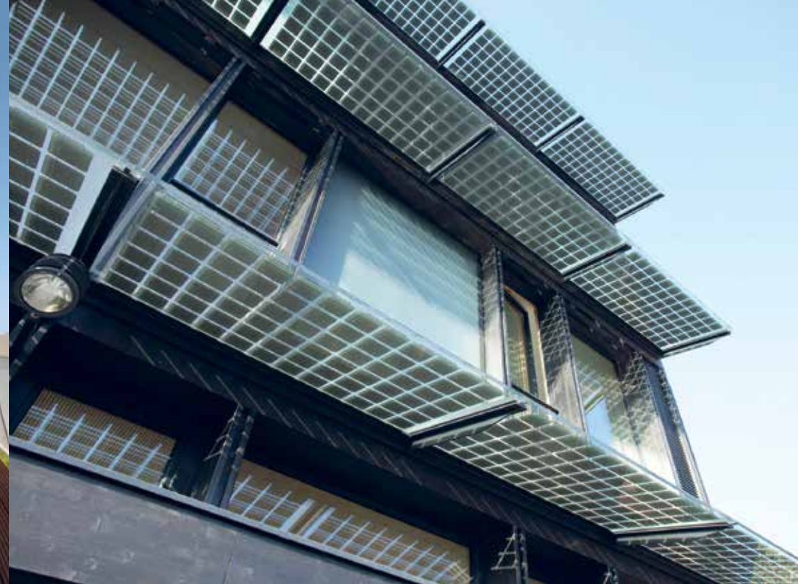
Sonnenschutzlamellen mit integrierten Photovoltaik-Elementen. Privates Wohnhaus. Architekt Pascal Gontier, Privathaus. Paris, Frankreich..
