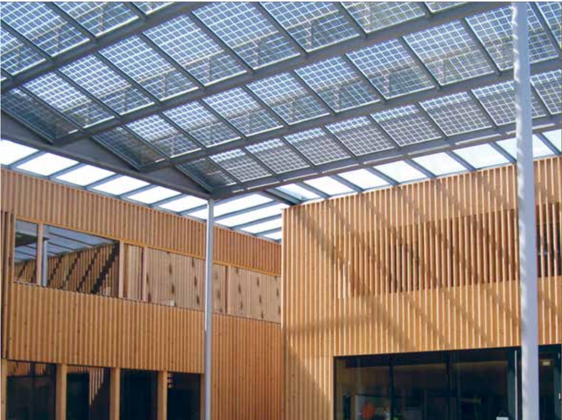
Dieses Glasdach eines Gemeindezentrums kombiniert Energieerzeugung und Sonnenschutz. Architekt Hermann Kaufmann, Glasdach Gemeindezentrum Ludesch. 6713 Ludesch, Raiffeisenstraße 56.
