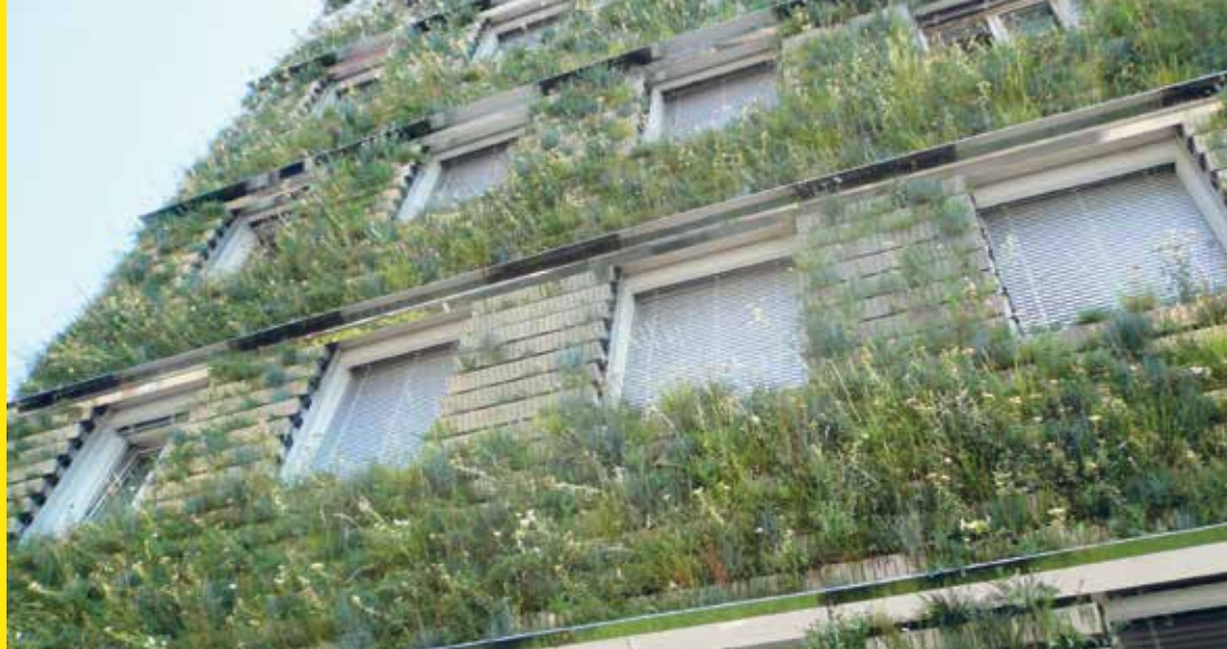
Fassadengebundene Begrünung am Gebäude der MA 48. 1050 Wien, Einsiedlergasse 2.
