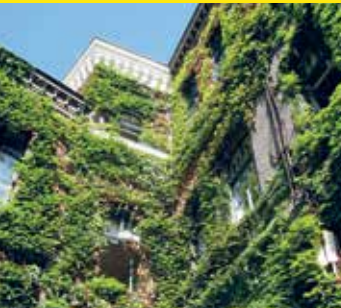
Bodengebundene Begrünung im WUK. 1090 Wien, Währinger Straße 59.
