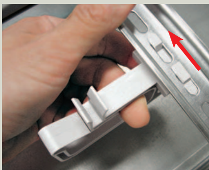
Encaixando um anel organizador de cabos para cabeamento horizontal
