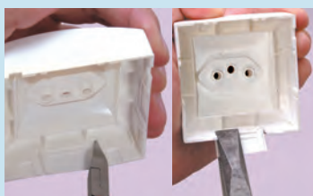
Remover o pré-corte da tampa do mecanismo para encaixar o acoplador
