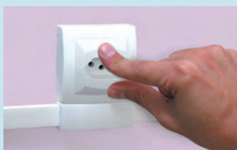
Encaixar a tampa à base do mecanismo
