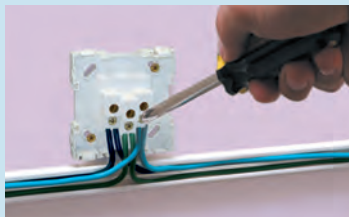
Passar os fios, cortá-los e conectá-los ao mecanismo
