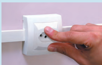
Encaixar a tampa à base do mecanismo
