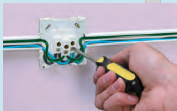
Passar os fios na canaleta e conectá-los ao mecanismo
