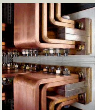
Conexão de 4 barras 100 x 10 em cada conexão traseira de um DMX 4000 extraível
