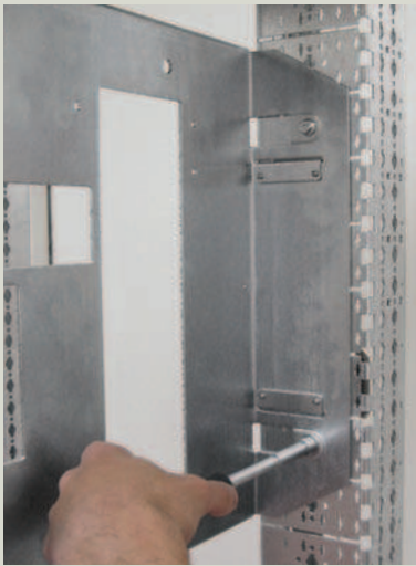
Travando a placa usando parafusos M6 e porcas de encaixe
