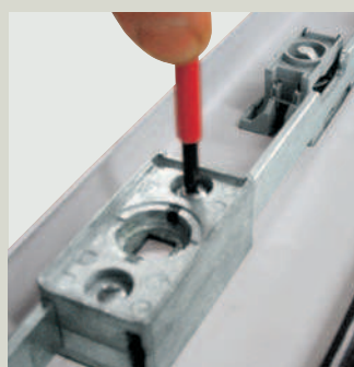
Desparafuse os 2 parafusos fixando a alavanca e o mecanismo
