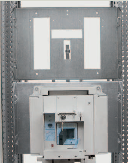
Inversor de fonte DPX 1600 sendo montado
