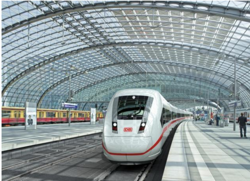
Figura 5 – Estação central de Berlin. Percebem-se os módulos translúcidos no canto superior direito na imagem em contraste com o restante dos vidros transparentes Fonte: Siemens.
