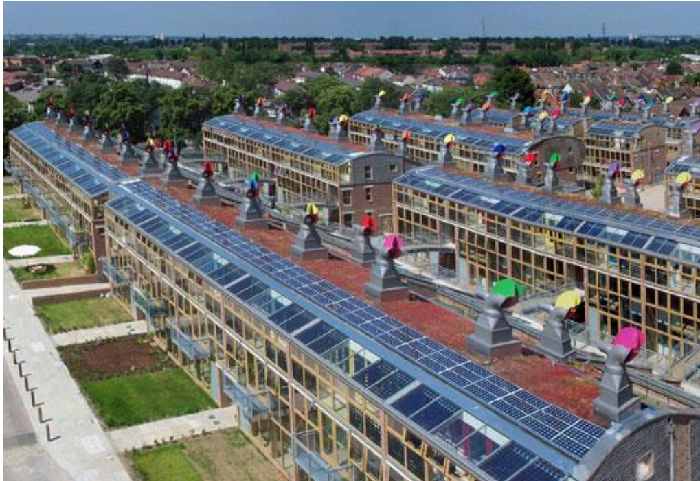
Figura 10 – Conjunto BedZED com instalação de sistema fotovoltaico na cobertura. Fonte: http://inhabitat.com/bedzed-beddington-zero-energy-development-london/
