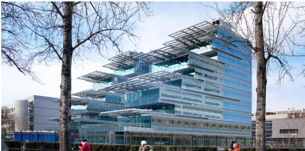
Figura 12 – Edifício SIEEB com inserção dos módulos fotovoltaicos nos brises.
