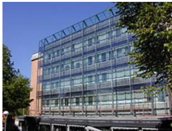
Figura 6- Universidade Trondheim com módulos nas fachadas. Fonte: http://www.ecw.org .
