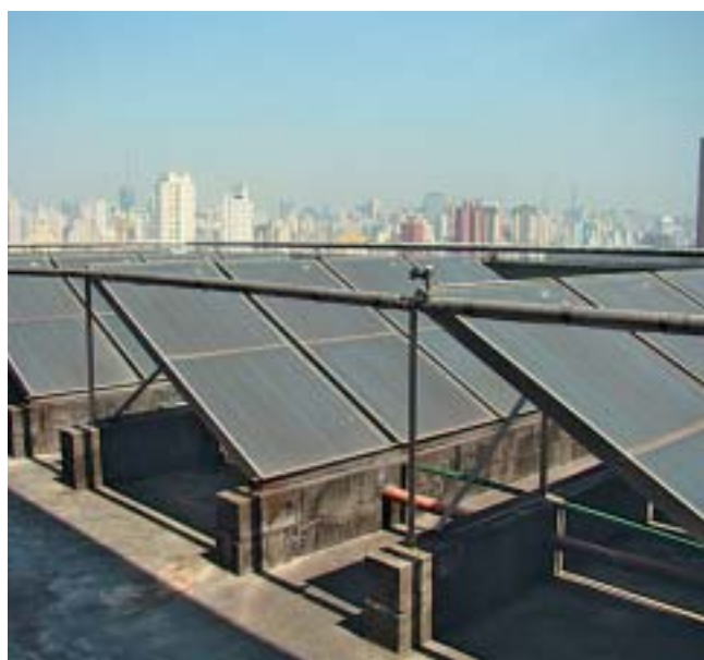
Foto: coletores solares Torre 1- Mundo Apto Cambuci
