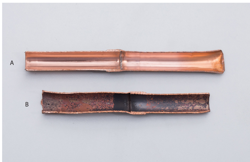
Figura 37 – (A) Solda com nitrogênio (N 2 ). (B) Solda sem nitrogênio (N 2 ).
