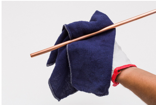
Figura 4 – Limpeza de tubo.
