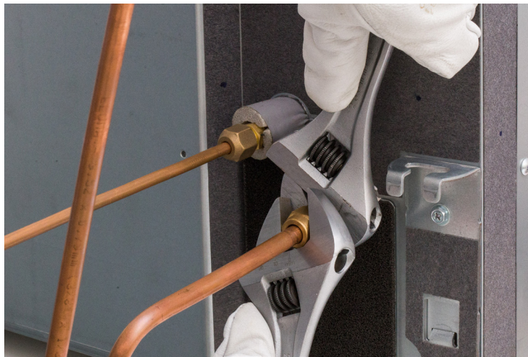
Figura 41 – Aperto das conexões.
