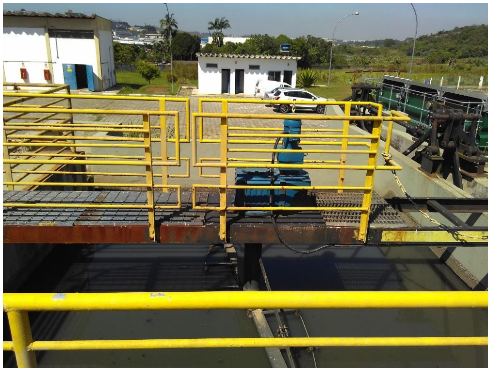
Figura 2 - Caixa de areia com raspadores mecanizados
