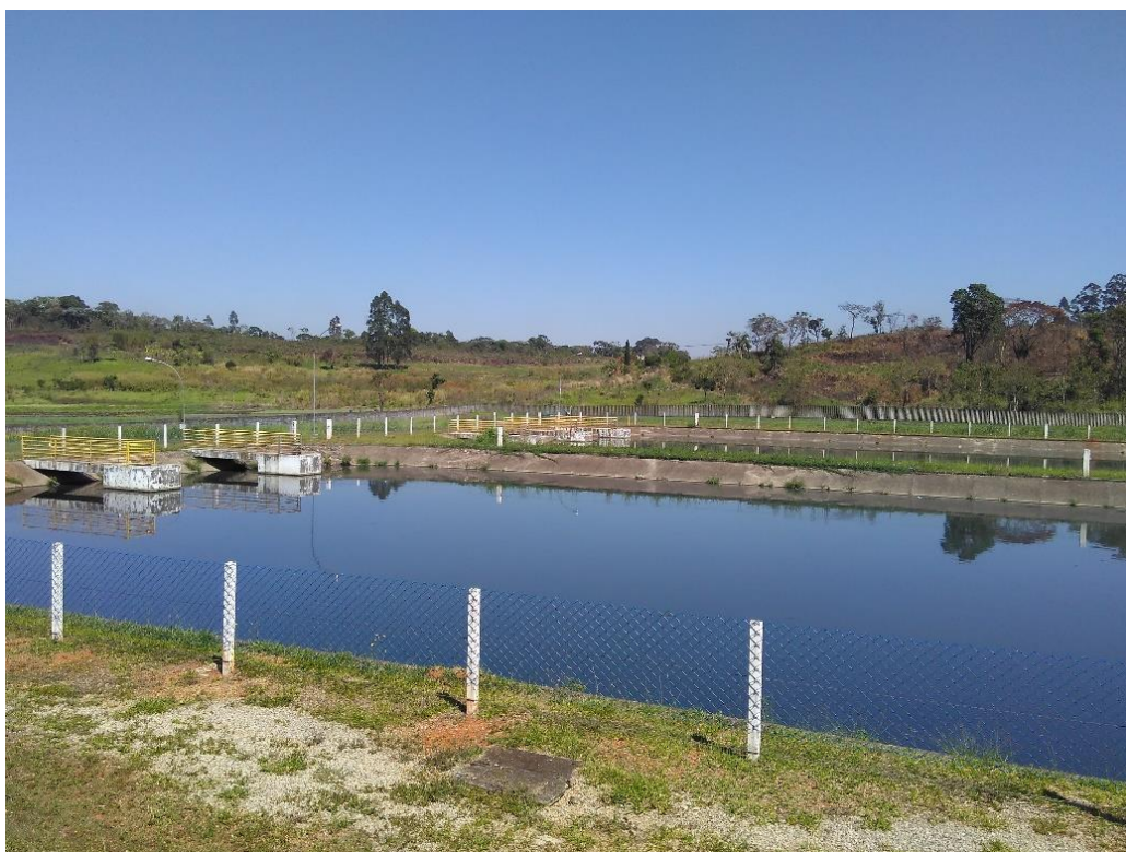
Figura 4 - Lagoa de decantação
