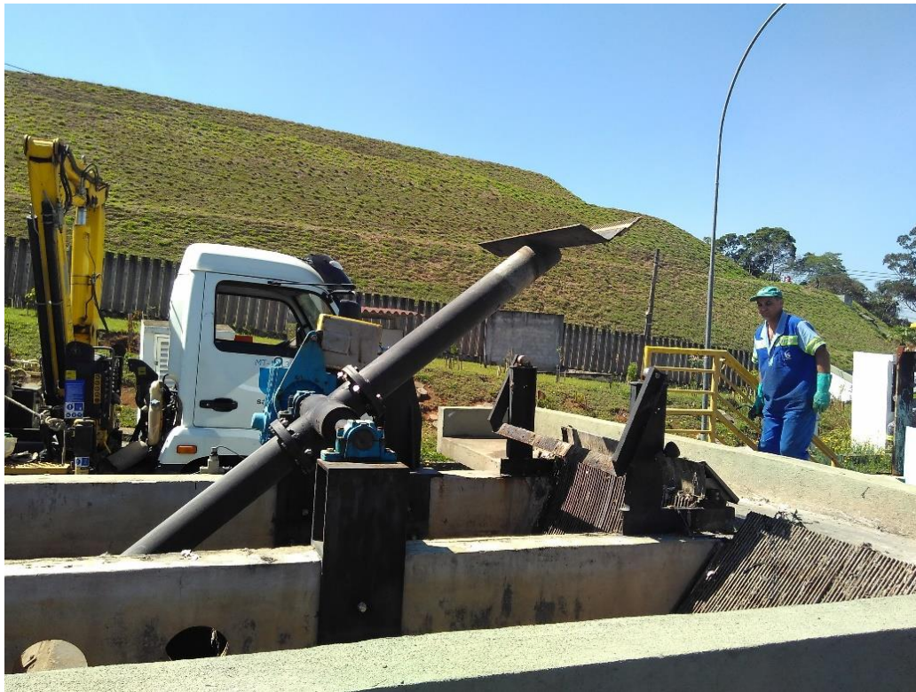
Figura 1 - Gradeamento mecanizado
