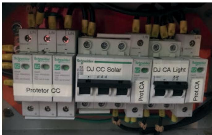
Imagem 1 - Dispositivos de CA utilizados em CC – arquivo pessoal do autor.
