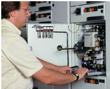
Inserção de uma gaveta extraível de 200 kW Insertion of a 200 kW drawer
