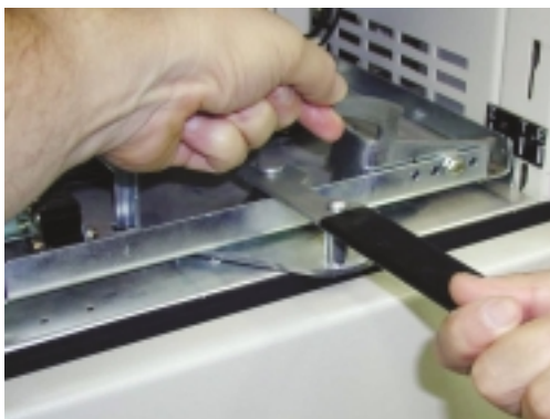
Blokset tipo Mw - Inserção ou extração da gaveta Blokset type Mw - Drawer insertion or extraction
