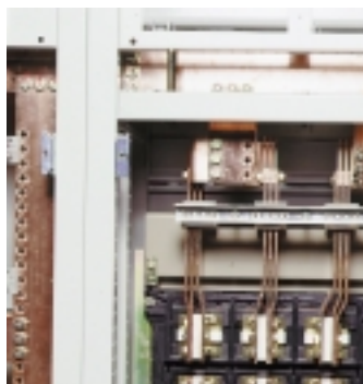
Blokset tipo D, jogo de barras Blokset type D, busbars
