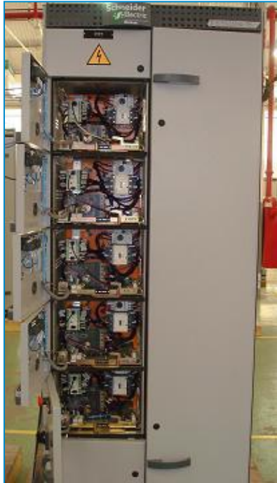
CCMi extraível com Coordenação Tipo 2
