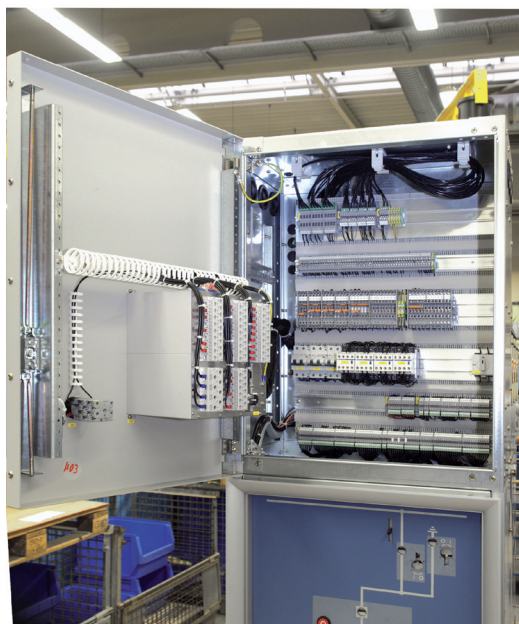
Compartimento de baixa tensão
