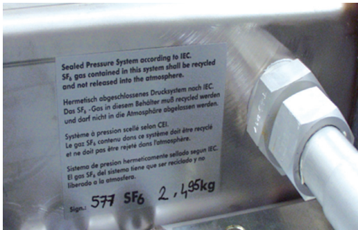
Válvula integrada com acoplador comercialmente disponível
