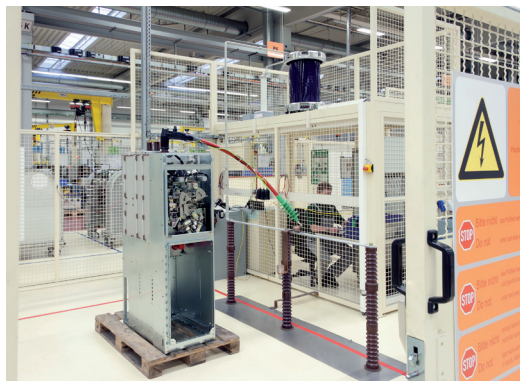
Teste de Alta Tensão
