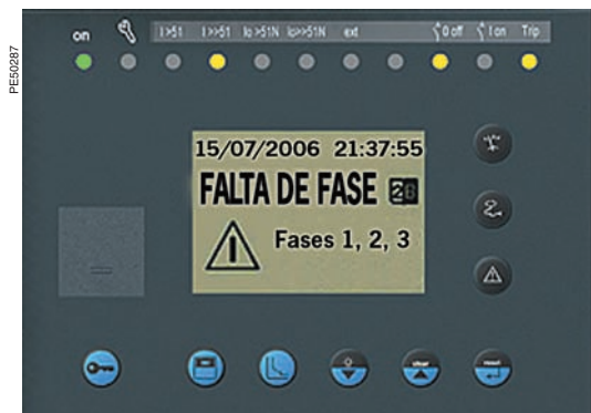
Sinalização local no painel frontal do Sepam.
