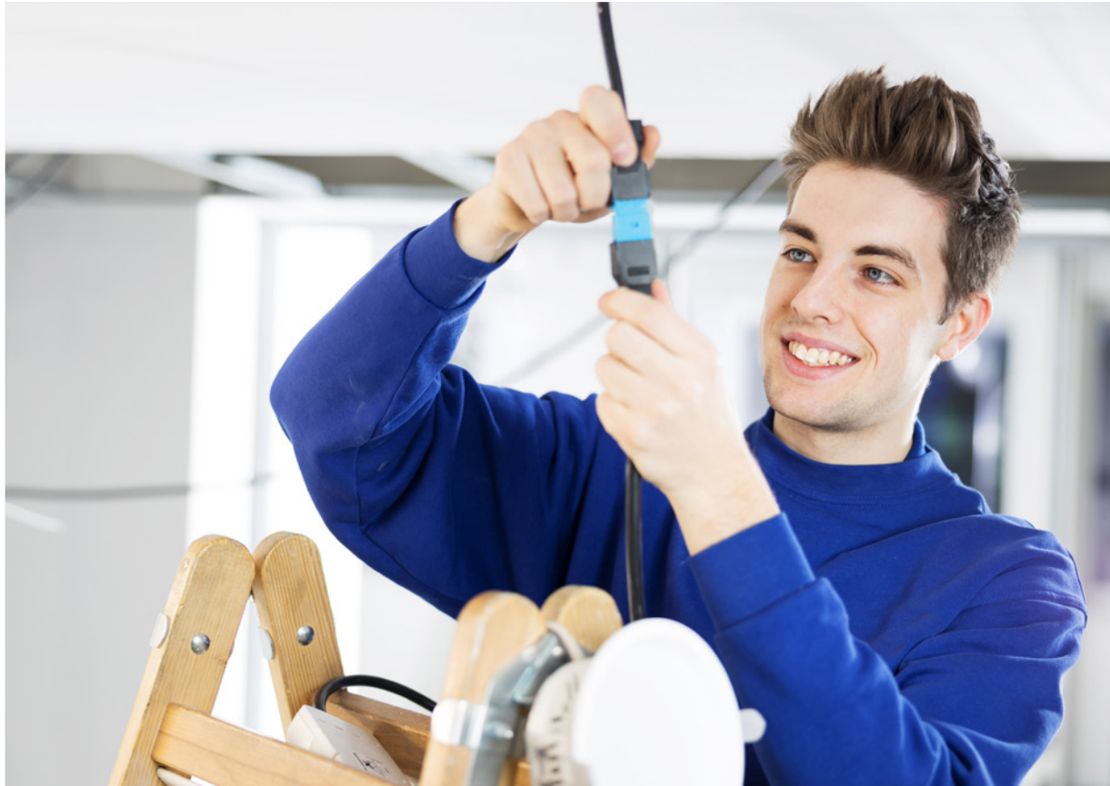
Downlights können in der Elektrowerkstatt mit WINSTA®-Leitungen ausgerüstet werden und müssen auf der Baustelle dann nur noch an das System angesteckt werden. Leuchten einhängen, einstecken – und alles funktioniert.
