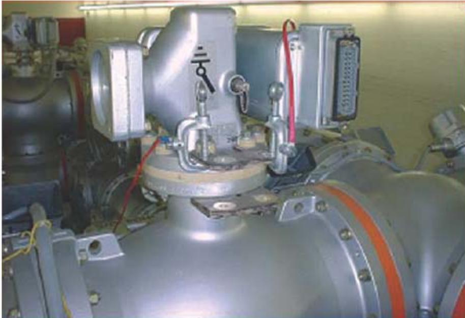
**Bild 5.** Konventionelle Art der Schaltzeitmessung: Die Anlage muss mit isolierten Erden ausgerüstet sein, da ein Zugangspunkt außerhalb des Gasraums benötigt wird. Der Erdungsschalter wird in diesen Fällen eingelegt, aber die Erdverbindung zum Messen außerhalb des Gasraums muss mechanisch aufgetrennt werden
