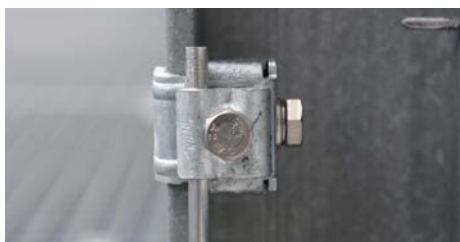
Blitzschutzpotentialausgleich mit Runddraht
