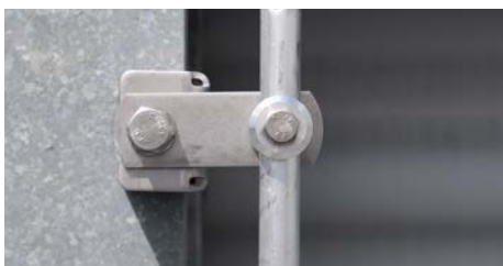
Montage Fangstange ohne Bohren
