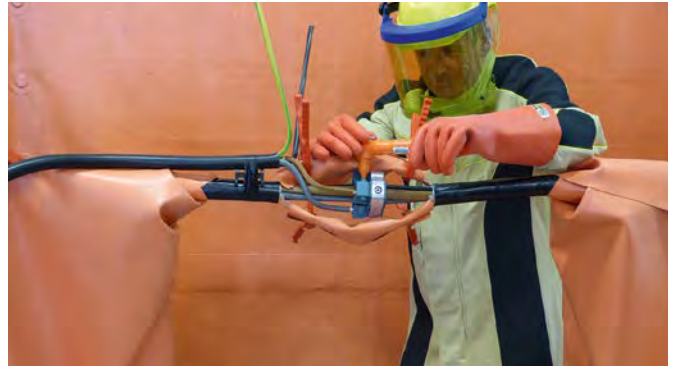
Abdecken von unter Spannung stehenden Teilen.
