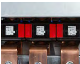
Eingebaute Schutzstromwandler
