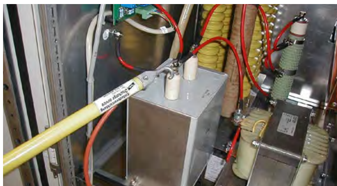
Einpolige Entladevorrichtung zum Ableiten statischer Ladungen.
