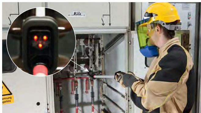
Spannungsprüfer PHG II an einer typgeprüften Schaltanlage.
