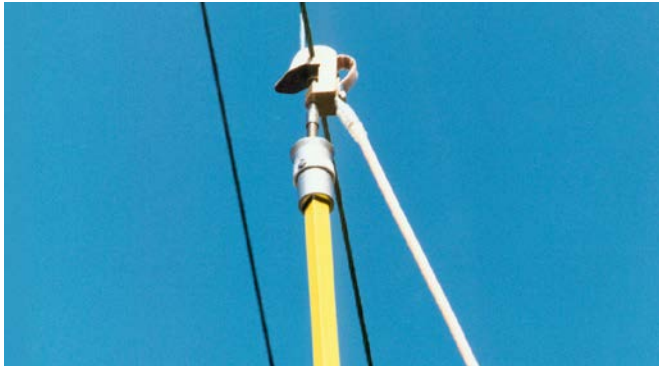
Einhängen der Fahrdrabt-Erdungsklemme in den Fahrdrabt.
