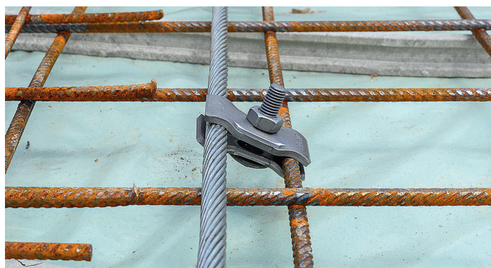
Verbindungsklemme für Fundamente der und Bewehrungen.
