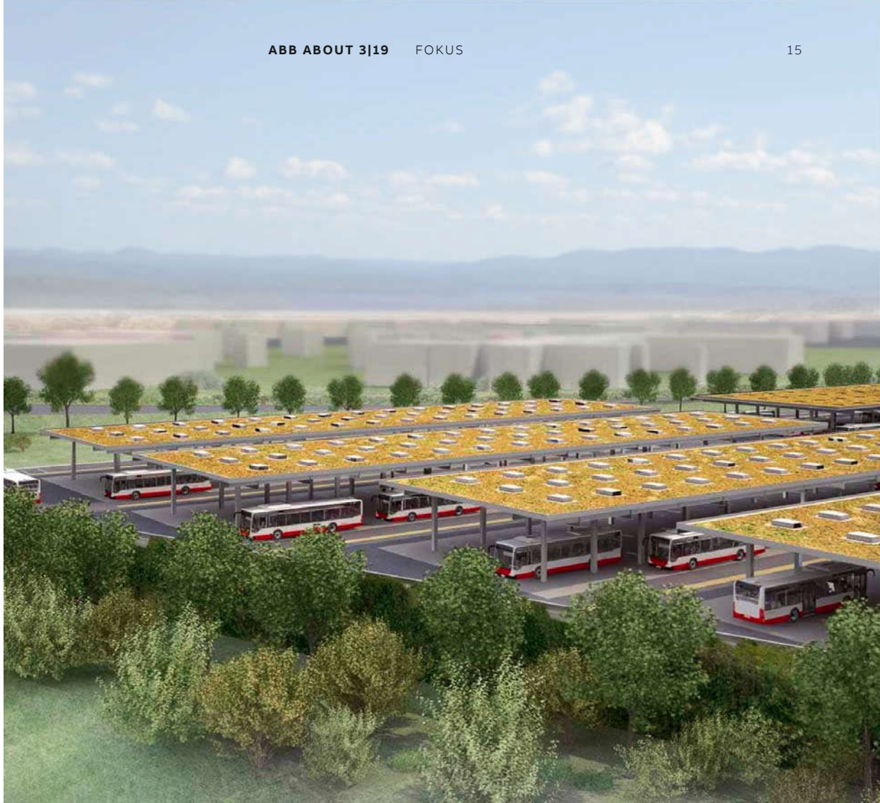
Das E-Bus-Depot der Hamburger Hochbahn wird mit 44 Hochleistungs-ladestationen von ABB ausgestattet werden.
