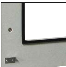
Brand- und Rauchschutz- dichtung umlaufend
