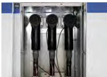
SF-6 Anlagenanschluss mit 480TB
