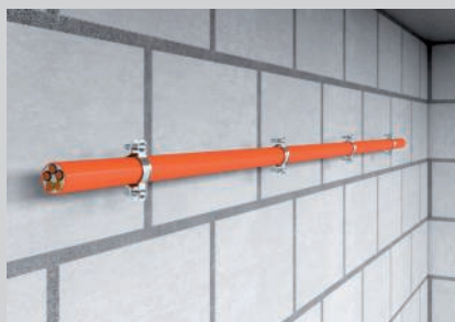
Waagerechte Montage der Kabel an der Wand.
