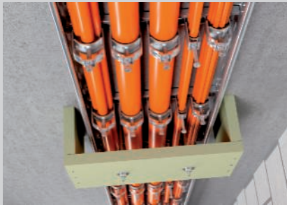
Montage über Kabelleiter.
