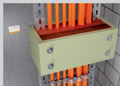
Fertig gefüllte Zugentlastung.
