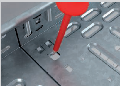
Umbiegen der Sicherungslaschen im Boden.
