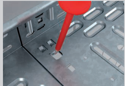
Umbiegen der Sicherungslaschen im Boden.
