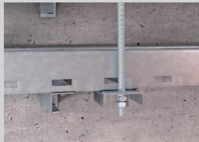
Befestigung der senkrechten Gewindestange am Anschlussbauteil.
