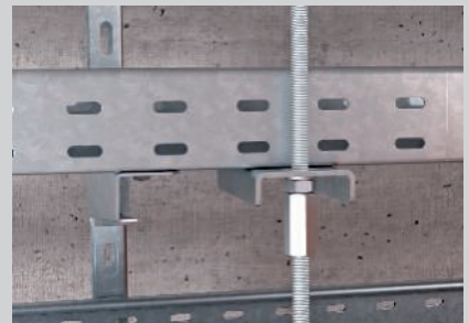
Gewindestangenbefestigung an der Rinne bei mehrlagiger Anordnung.
