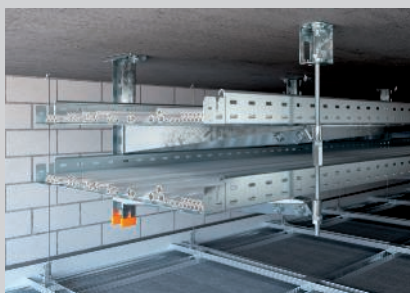
Zweilagige Deckenabhängung mit einseitiger Auslegeranordnung.
