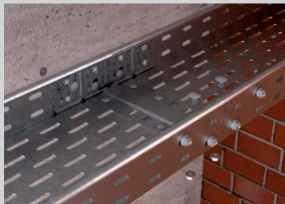
Längsverbinder und Stoßstellenleiste mit Flachrundschrauben befestigen.
