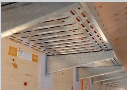
Auslegermontage seitlich am Holzbalken mit hinterlegter Brandschutzplatte.
