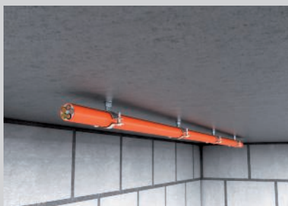
Montage unter der Decke.
