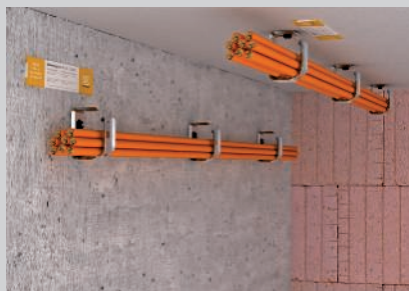
Fertig montierte Sammelhalterung 2031 M 15.
