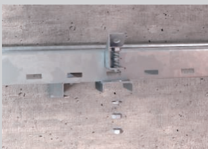
Montage des Anschlussbauteils schräg mit Sechskantschraube und Sechskantmutter.
