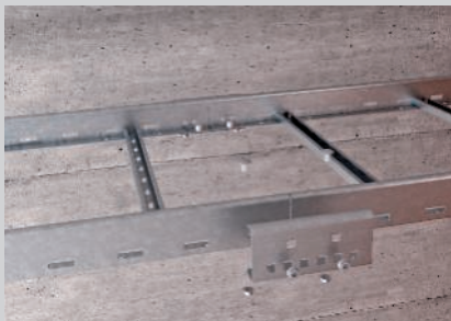
Montage der Längsverbinder mit Flachrundschrauben.
