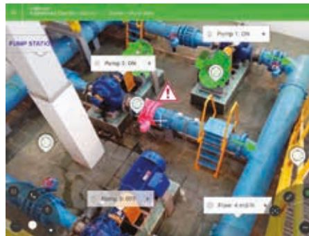
Außenbereich der Industrieanlage
