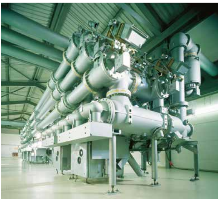
In der Hoch- und Mittelspannung dient SF6 zur Vermeidung von Schaltfunken. testo 6740 überwacht kontinuierlich die Feuchte – so können die Austauschzyklen des teuren Gases maximiert werden. Schäden werden vermieden.
