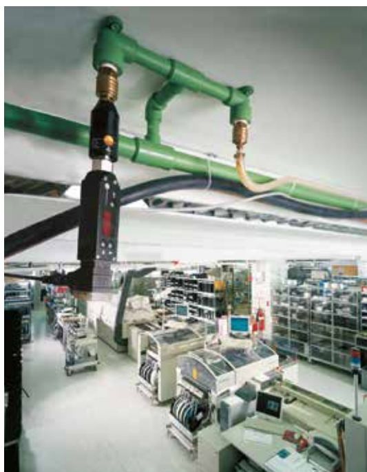
Bei kritischen Anwendungen überwacht der testo 6740 die Druckluftfeuchte direkt vor dem Verbraucher – z. B. in der Elektronikfertigung.
