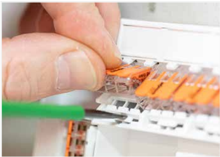
Klemme aus der Aufnahme lösen.
