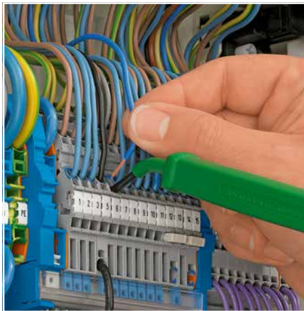
Öffnen der Klemmstelle mit Betätigungswerkzeug
