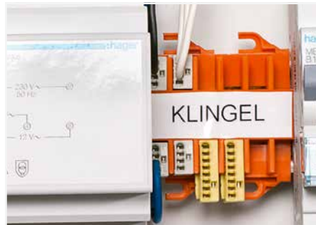
Anwendung für eine Hausklingelanlage – Befestigung auf Tragschiene 35
