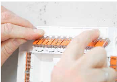
Beschriftungsstreifen in die Aufnahme einrasten.
