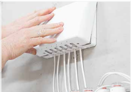
Deckel der Verbindungsdose aufrasten.
