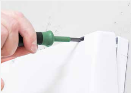
Deckel der Verbindungsdose öffnen.
