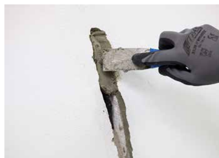
Schadstelle unsichtbar verschließen.
