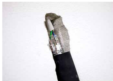
Leitung mit Leitungsreparaturset verbinden.
