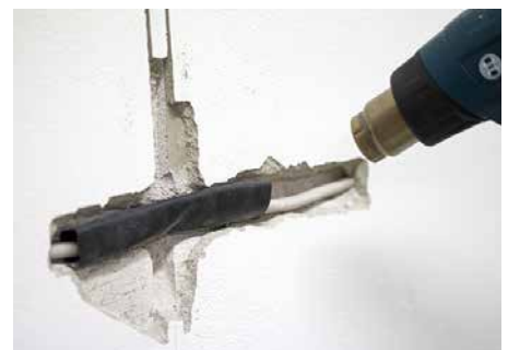
Schrumpfschlauch erhitzen und Schadstelle wieder fachgerecht verschließen.
