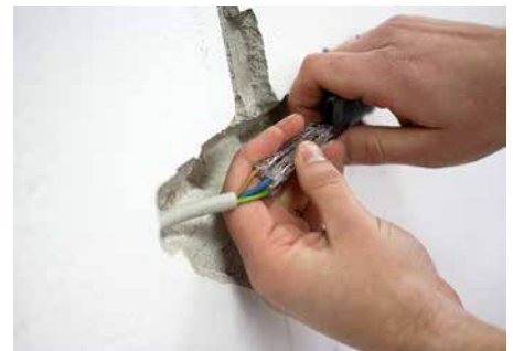
Leitung mit Leitungsreparaturset verbinden.
