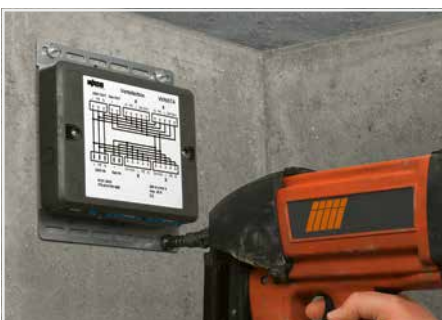
Montageplatte mit montierter WINSTA®-Box an der Wand befestigen (z. B. mit Bolzenschubgerät).
