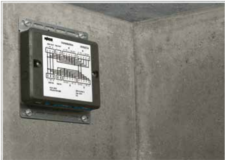
WINSTA®-Verteilerbox an der Wand befestigt
