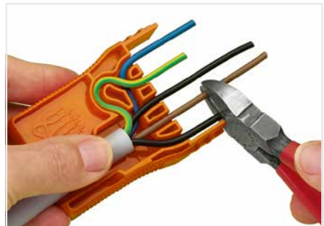
Abgemantelte Leitung in die Verdrahtungshilfe einlegen und die einzelnen Adern entsprechend der Beschriftung, bei N beginnend, ausrichten. Leiterenden auf richtige Länge bringen.
