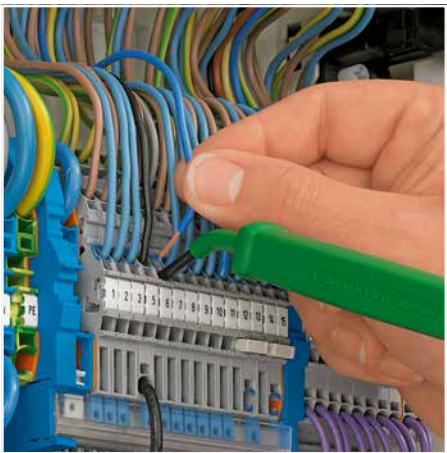
Öffnen der Klemmstelle mit Betätigungswerkzeug
