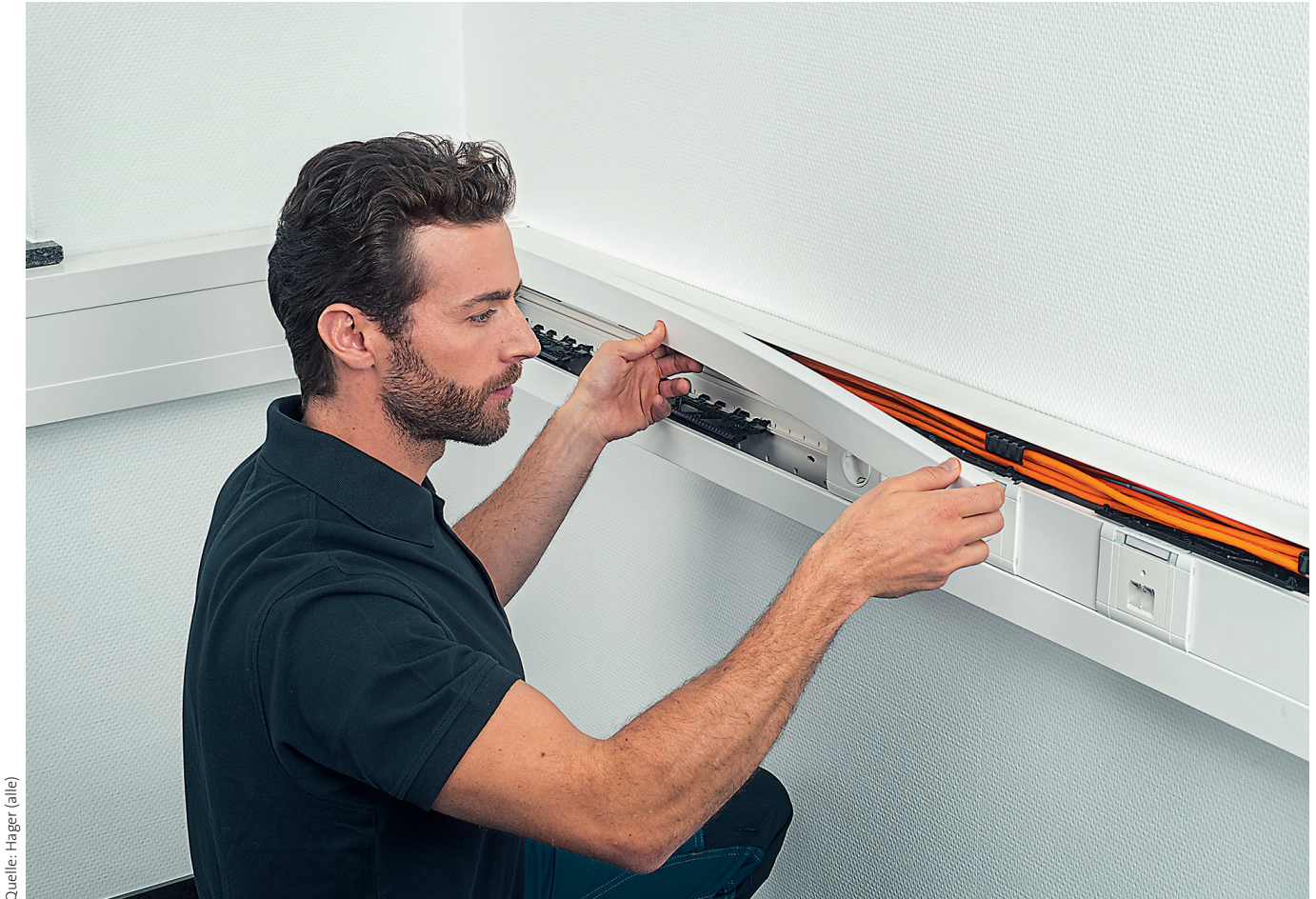
Bild 1: Die abnehmbaren Seitenoberteile lassen sich einfach aufbringen und auch verwindungsfrei wieder nach vorne abziehen
