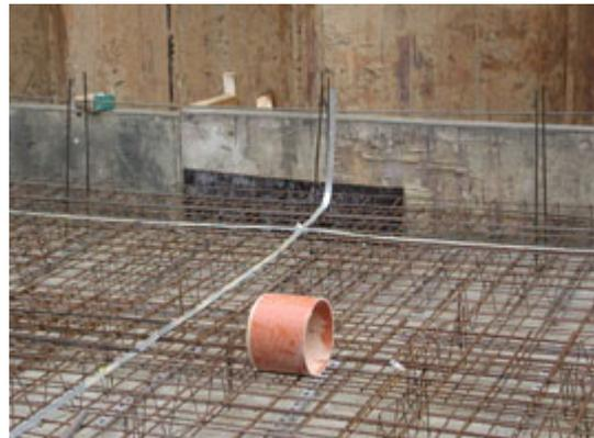
Um einen korrekten Potentialausgleich zu realisieren ist dieser nach DIN VDE 0100 auszuführen. Grundsätzlich gilt es dann alle metallischen Bauteile eines Gebäudes und die Elektroleitungen (Leitungsschirme und PE Leiter) auf ein gemeinsames Potential zu bringen und mit einem Haupterder mit dem Erdpotential zu verbinden.
