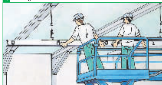
3 Anbringen der Schienenkästen
