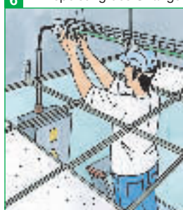
6 Einspeisung des Strangs
