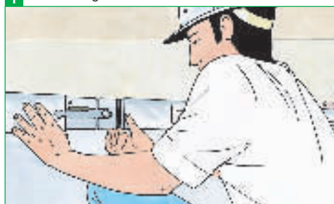
1 Vorbereitung des Schienenverteilers am Boden
