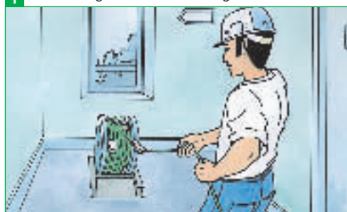
1 Vorbereitung der Abrolleinrichtung
