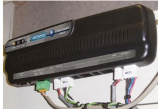
Alarmmeldungen über kritische Zustände werden an die USV, aber auch per SMS und E-Mail an den jeweils zuständigen Service weitergeleitet. Eine kurzfristige Reaktion auf das Batterieproblem ist unmittelbar möglich. Ein vollständiges Batterie-System-Monitoring (CellGuard) ist seit Ende 2007 vom Amerikanischen Batteriespezialisten Midtronics verfügbar. CellGuard erfasst alle Parameter der Batterieanlage und stellt diese Online zur Verfügung.
