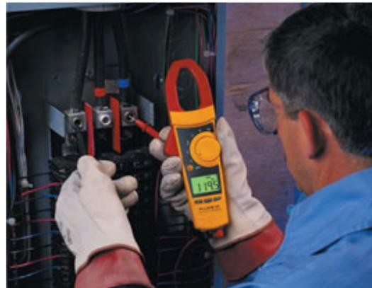
Strommesszangen messen den Strom, indem sie das magnetische Feld um einen stromführenden Leiter bestimmen. Das Unterbrechen dieser Stromkreise zum Messen im Stromkreis ist unpraktisch und kann sogar Stillstand oder Schäden verursachen, wenn Sie dadurch versehentlich einen kritischen Stromkreis auftrennen! Üblicherweise werden die Messungen am Schaltschrank durchgeführt und umfassen die Prüfung des Stroms an jeder Einspeisephase.
