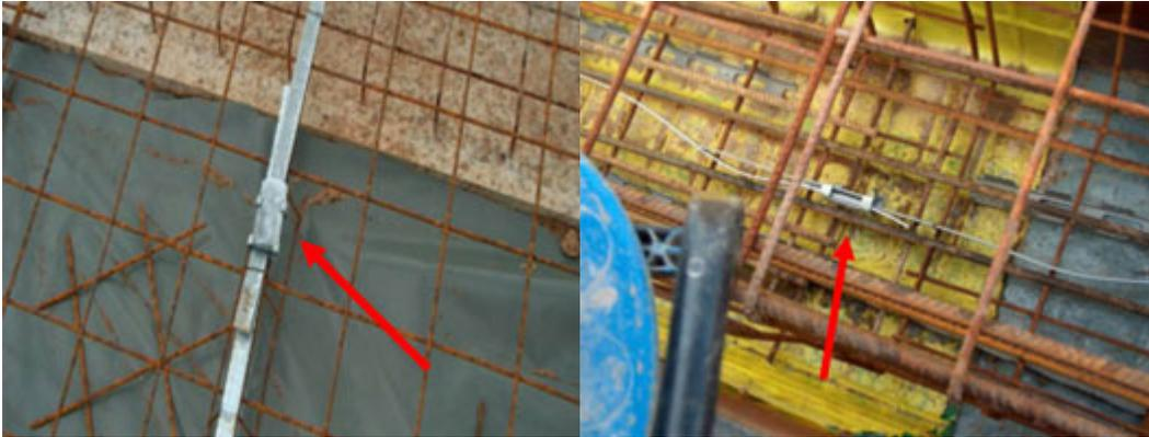
Bild 4: Schlecht montierte Keilverbinder - die Anwendung ist bei maschinell verdichtetem Beton nicht mehr zulässig
