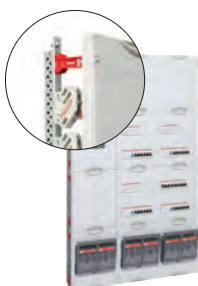
Variante 1: Einbau Montageplatte (Ausbau für die Steuerungstechnik mit Montageplatte)
