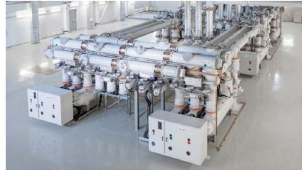
En las subestaciones compactas (GIS) > 52 kV hasta 400 kV
