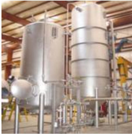
Control de silos
