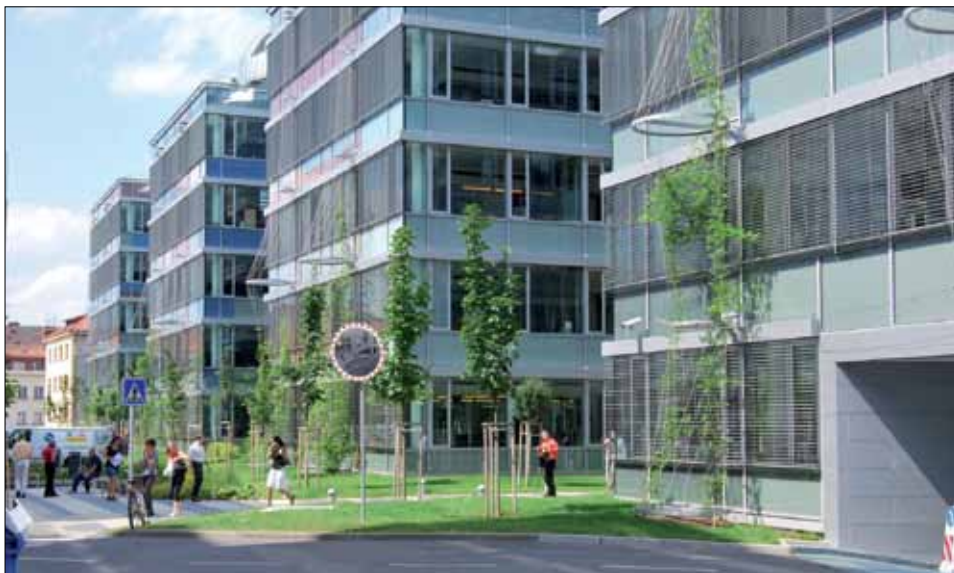
El sistema de protección solar, controlado por KNX, contribuye sustancialmente al ahorro energético
