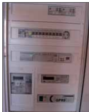
Aula con control de la iluminación, protecciones solares, automatización KNX y Smart Metering
