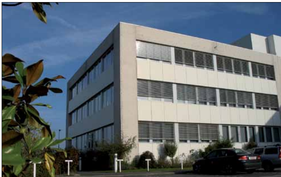
Un sistema de protección de sol controlado por sensor reduce la carga de refrigeración
