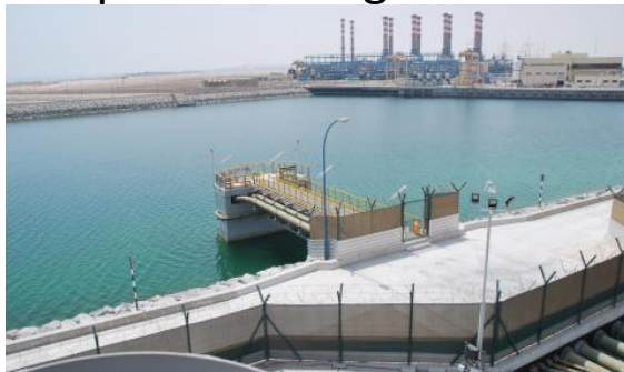
Captación de agua natural
