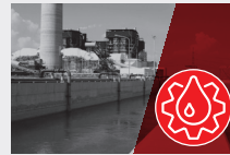
Tratamiento de agua Water treatment
