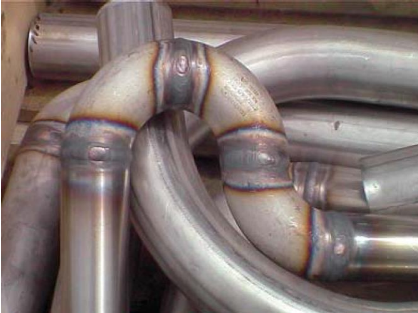
Soldadura Inox: Alteración superficial
