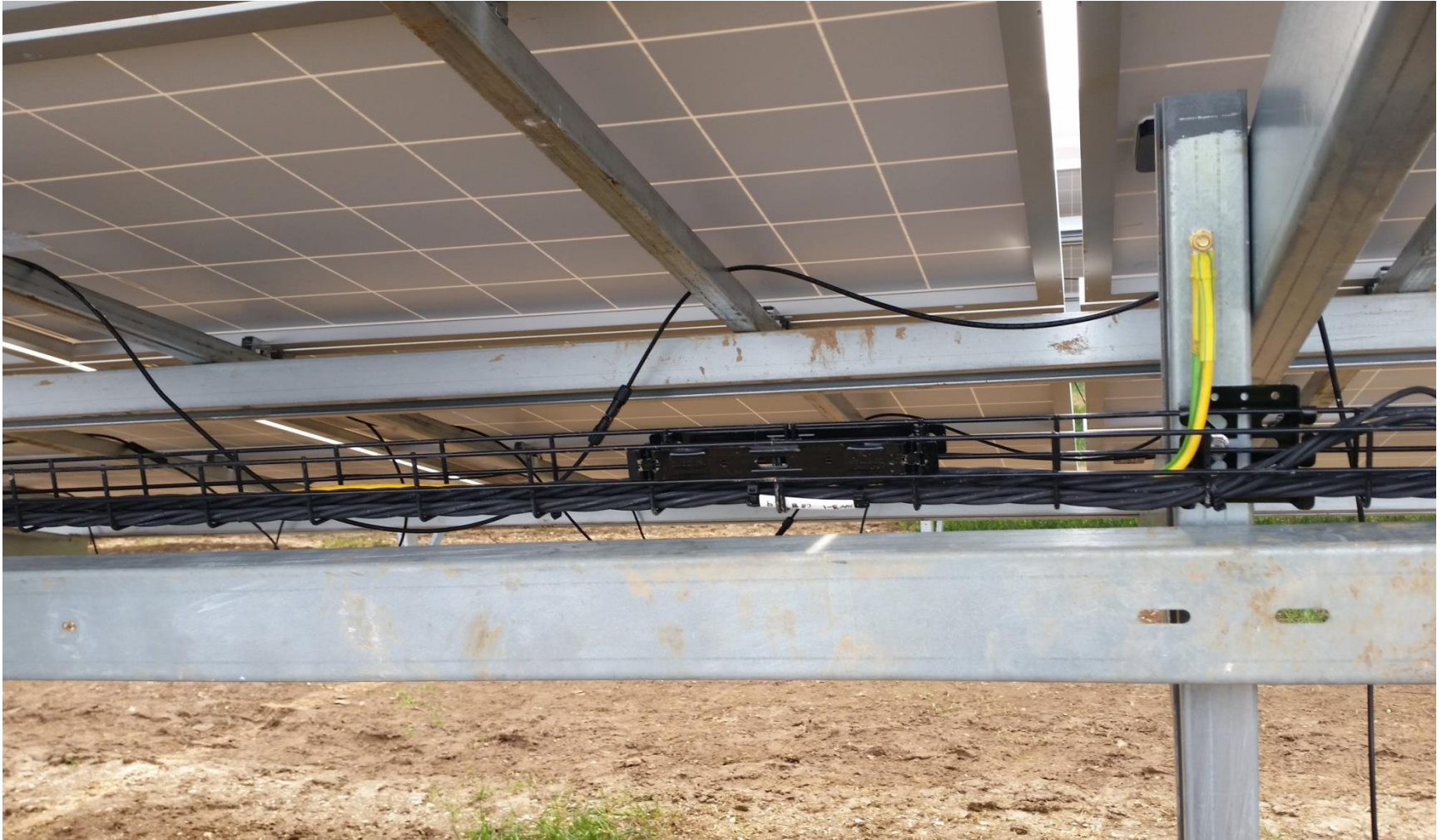
Conexión del Sistema de Bandejas
