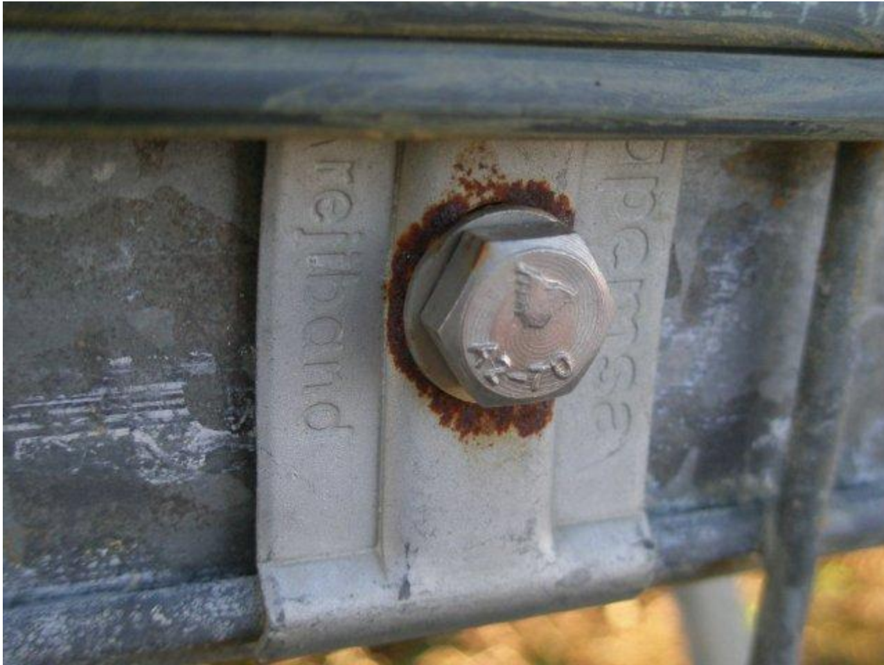
Accesorio GC con tornillo Inox en ambiente extremo
