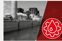
Tratamiento de agua Water treatment
