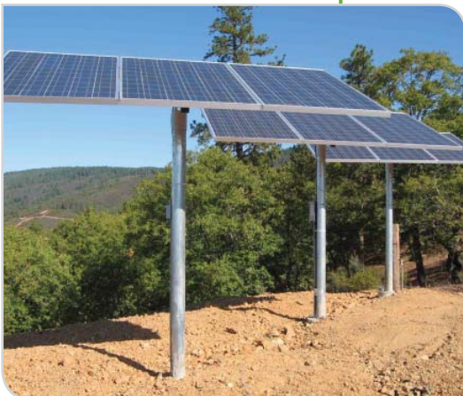
> Instalación aislada de 4,5 MW (California, EE. UU.)
