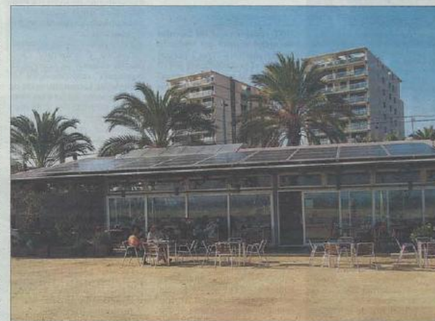
Restaurante en Mataró con una cubierta fotovoltaica para autoconsumo. / CONERGY
