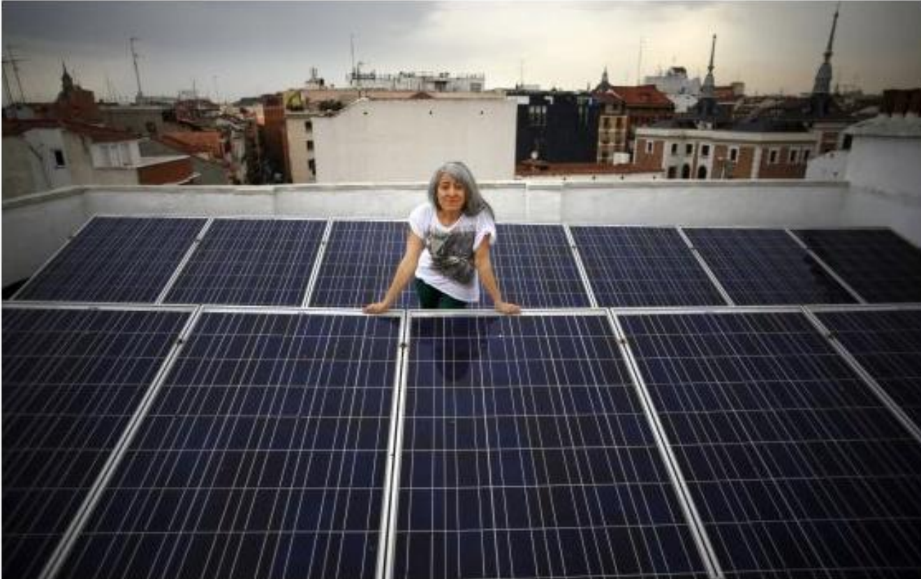
Montse Romanillos, en la azotea del edificio donde vive y cuya comunidad autoproduce parte de la energía que consume en las zonas comunes. / SAMUEL SÁNCHEZ
